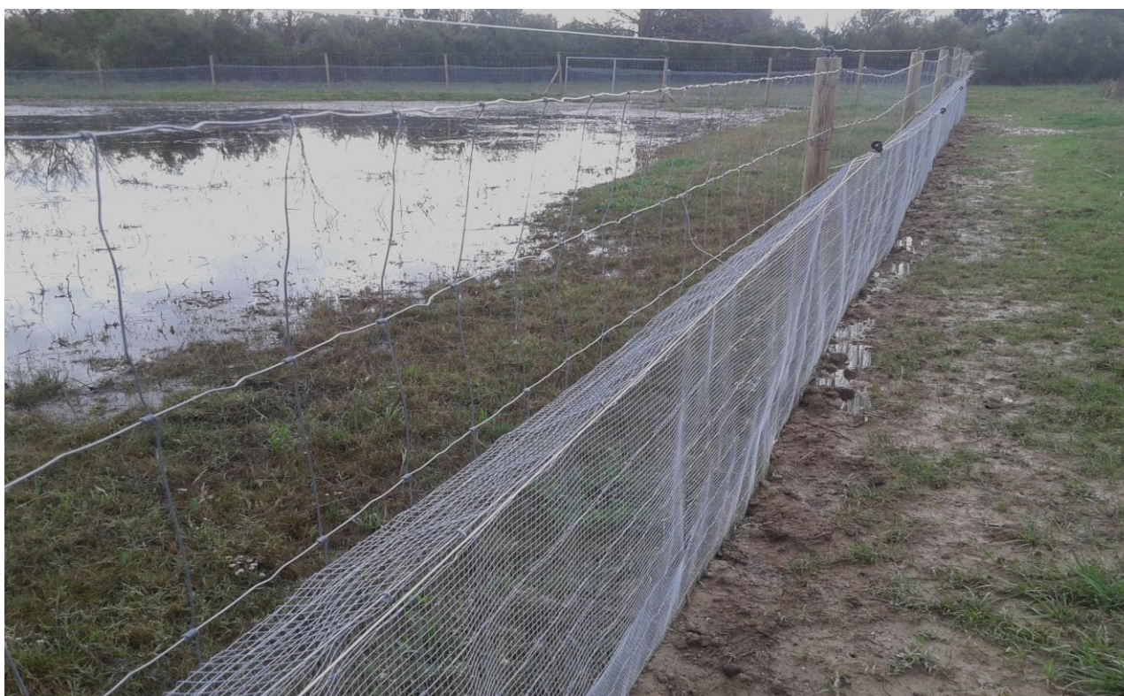
Figura 1.7. Tanca de malla nuada per evitar accés de senglar i altres ungulats complementada en aquest cas amb malla electrosoldada per evitar accés de visó americà en una zona humida d'alt interès de conservació.
