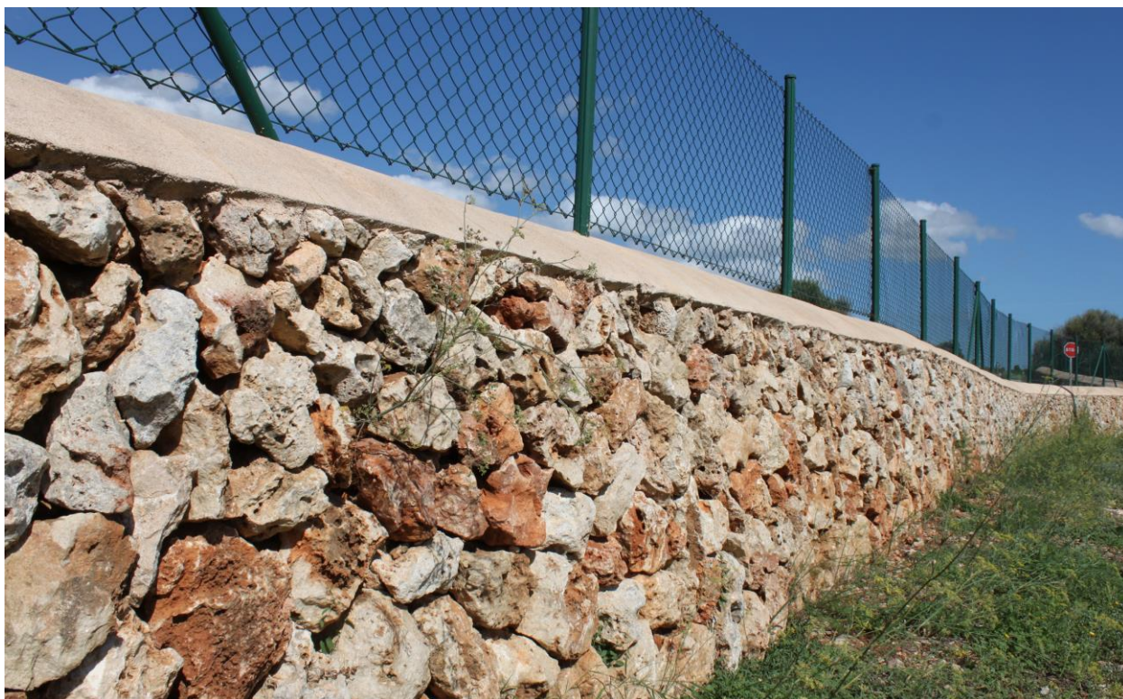
Figura 1.3 Mur de paret seca adequat per prevenir accés de fauna i malla superior complementària per dificultar el pas de persones.
