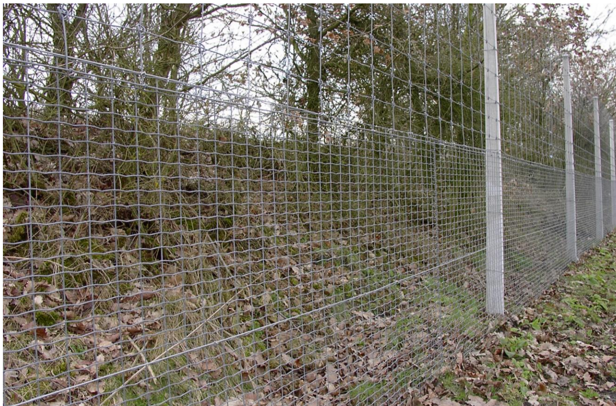
Figura 1.8. Tancament que combina malla electrosoldada per a petita fauna (part inferior) i malla nuada per a ungulats (part superior).
