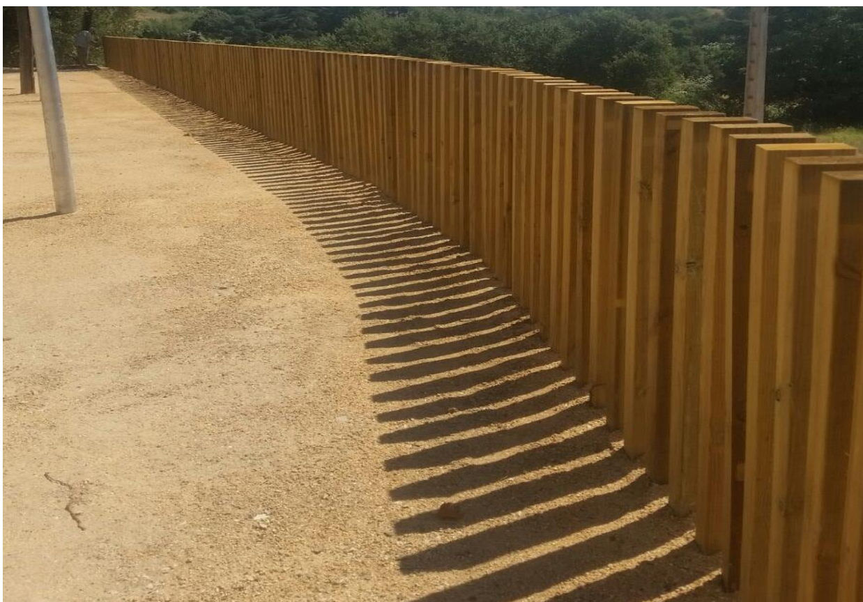
Figura 1.4. Tancament d'una zona verda urbana amb pals verticals de fusta que permet prevenir l'accés de senglar.
