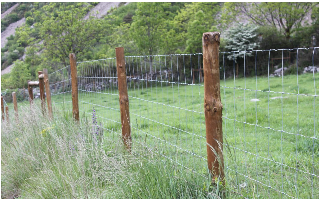
Figura 1.2. Tancament amb malla nuada de densitat progressiva i pals de subjecció de fusta, adequat per a entorns rurals.
