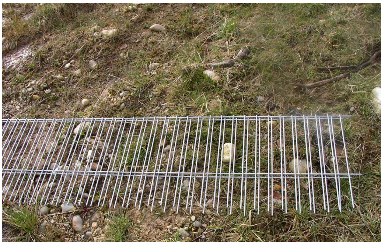
Figura 2.3. El fil horitzontal de la base de la malla de reforç s'ha tallat de manera que clavar-lo amb més facilitat al terreny.
