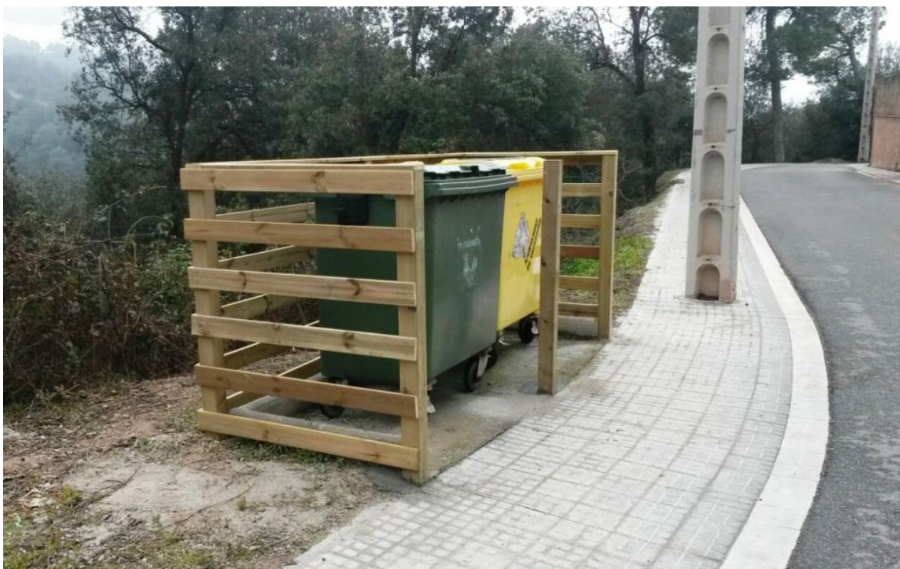
Figura 9.1. Contenidors amb tancament perimetral parcial que impedeix que els animals els bolquin. Font: www.vacarisses.cat
