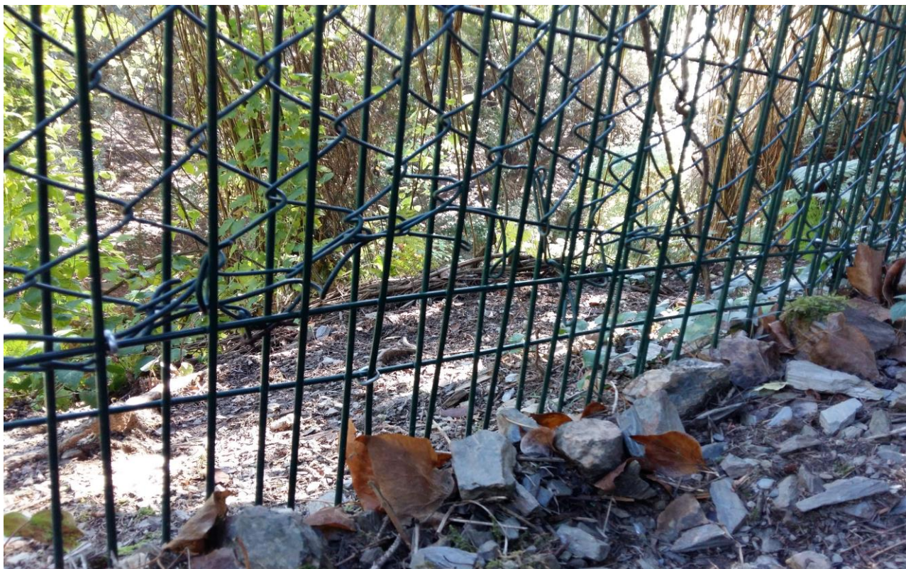
Figura 2.4. Reparació de desperfectes d'una malla de torsió amb reforç de malla electrosoldada adequat per a senglar.
