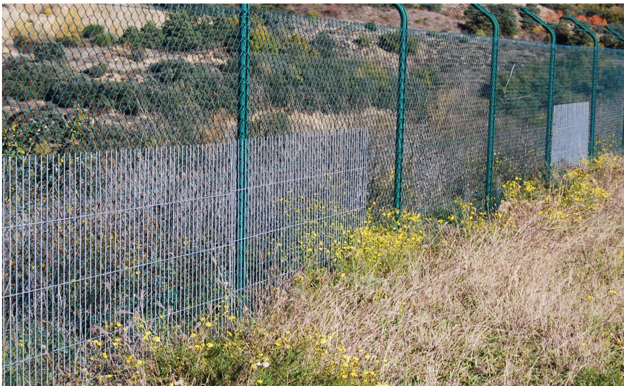
Figura 2.2. Reforç d'un tancament de malla de torsió mitjançant malla electrosoldada al tram inferior.
