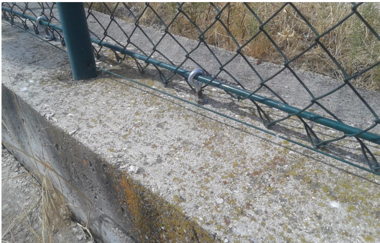
Figura 2.6. Anclatge de la malla a un muret mitjançant una vara metàl·lica horitzontal.
